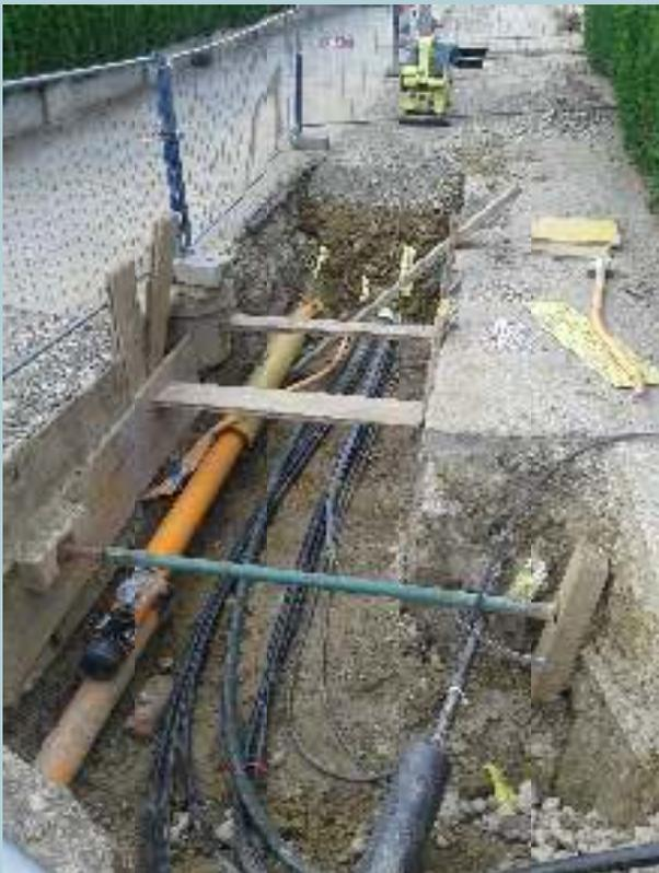
**Am Steig:** Verlegungsarbeiten der Gas-, Wasser- und Stromleitung, sowie der Straßenbeleuchtungskabel, Glasfaserleerverrohrung und auch das letzte Telekomkabel in Natschbach liegt jetzt unter der Erde.
